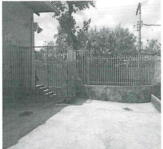
12. Pintura de superfícies metálicas.
