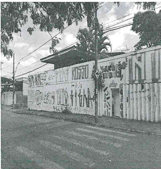
13. Pintura do muro da escola.
