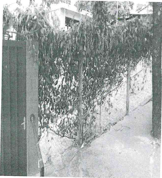
1. Construção parcial de muro.
