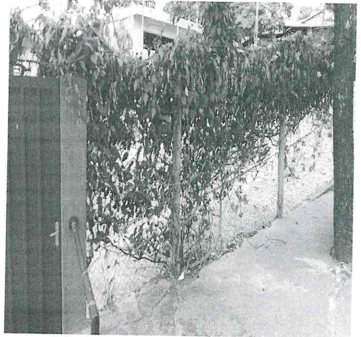
2. Construção parcial de muro.
