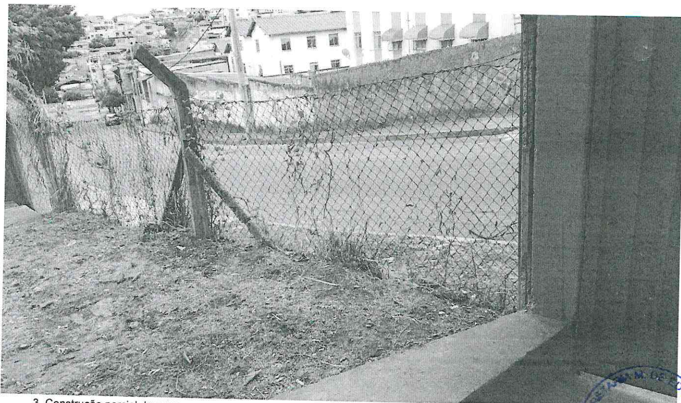
3. Construção parcial de muro.
