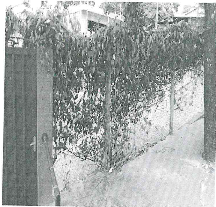
2. Construção parcial de muro.
