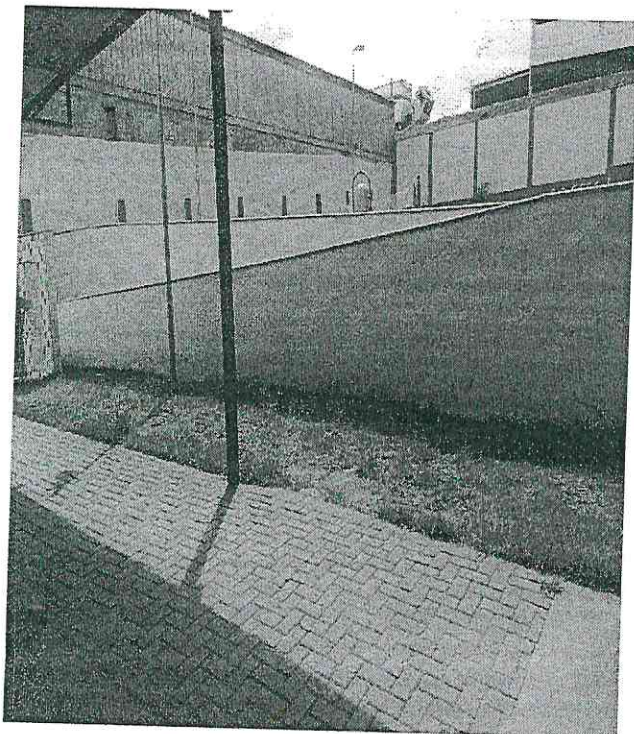
1. Área onde será instalada a arquibancada.
