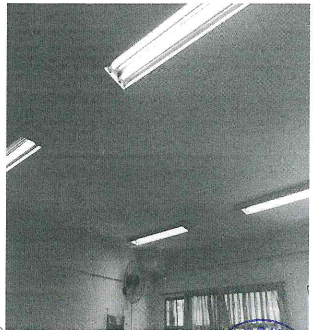
7. Substituição de lâmpadas comuns por fluorescentes.
