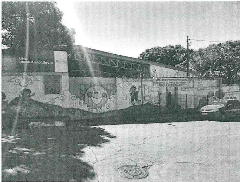
1 – Pintura do muro
