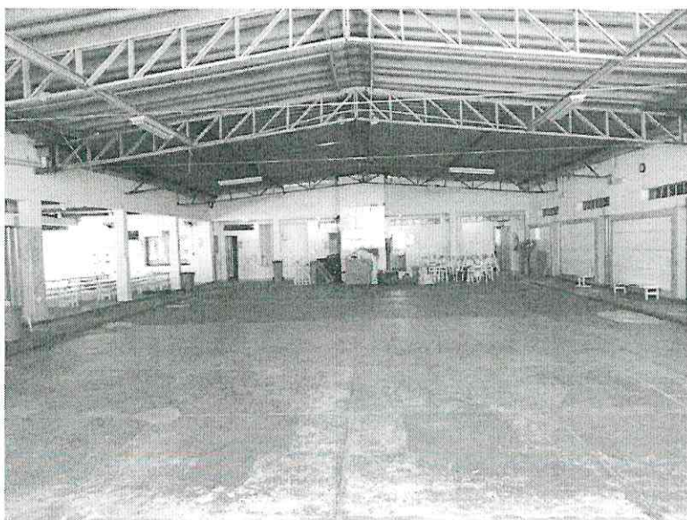
4 – Reforma do piso do pátio
