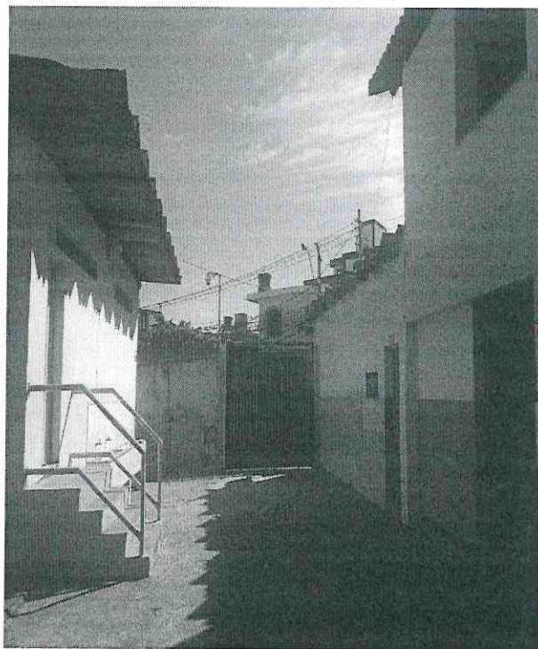
2. Cobertura para acesso do bloco à sala de artes.
