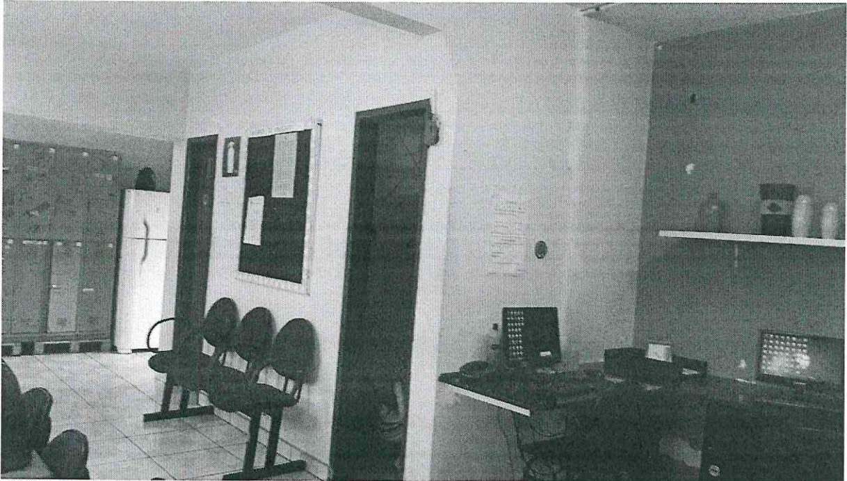
4. Banheiro dentro das salas dos professores – realocar para outra área.
