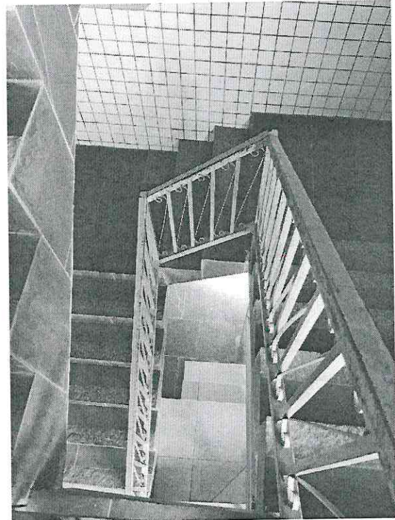
Figura 8: Instalar guarda-corpo e corrimão na escada
