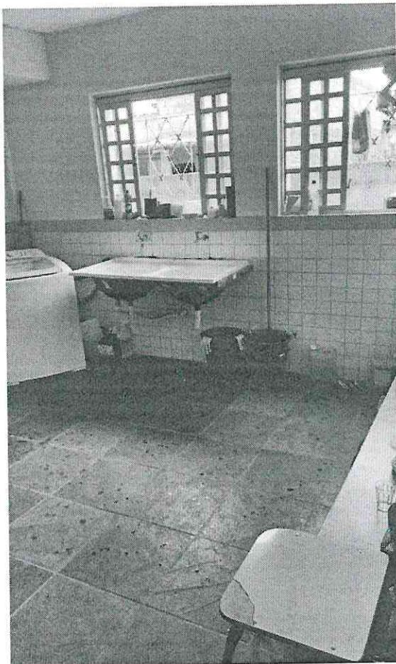
Figura 6: Lavanderia onde ficará o gás
