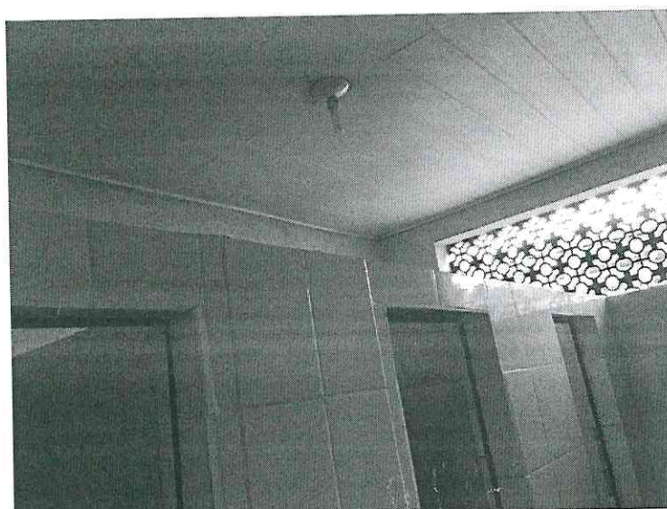
Figura 3: Divisórias de alvenaria
