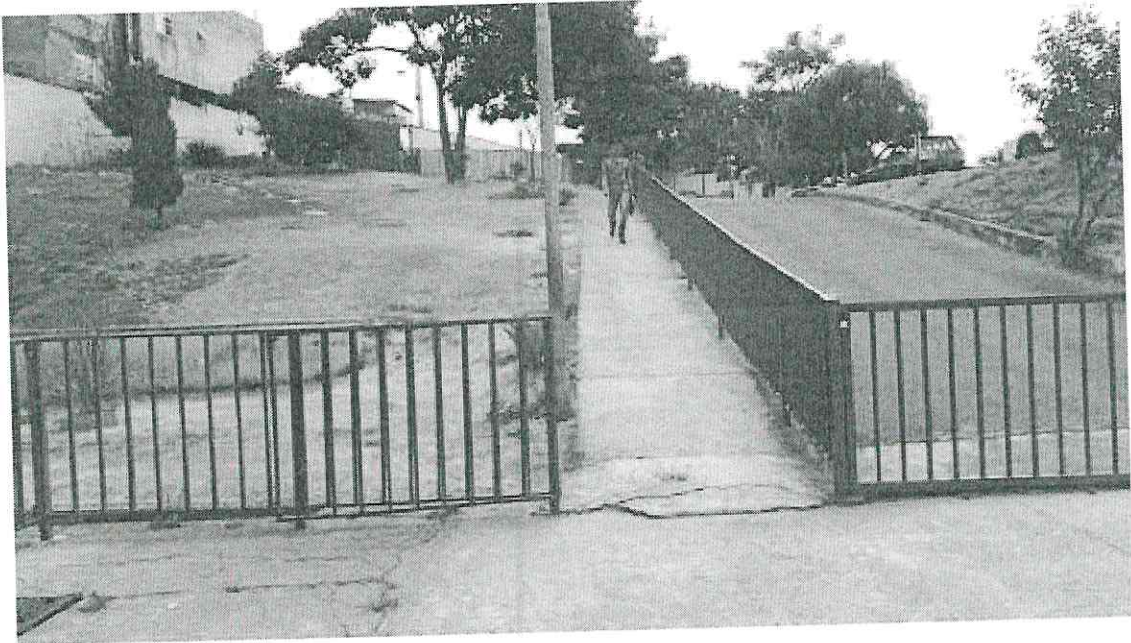
Rampa de acesso a portaria de entrada
