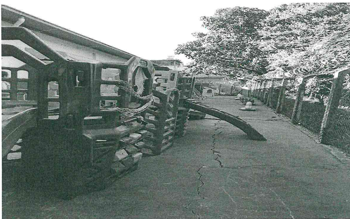
Figura 5: Local para instalação de cobertura
