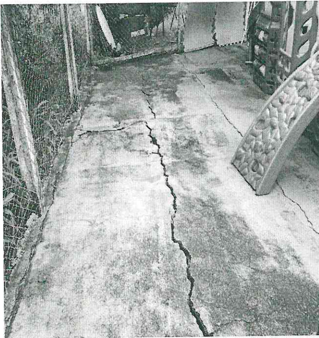
Figura 1: Fendas no piso, proveniente do deslocamento do solo.
