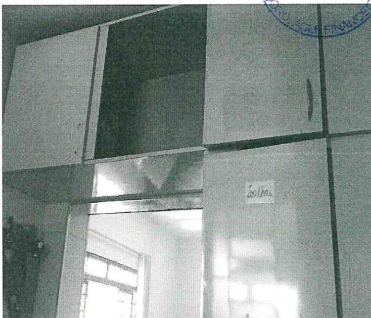
Figura 4: Demolição de armário
