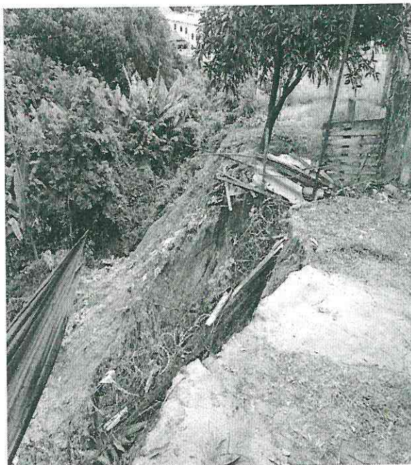
Outro ângulo de visão da erosão
