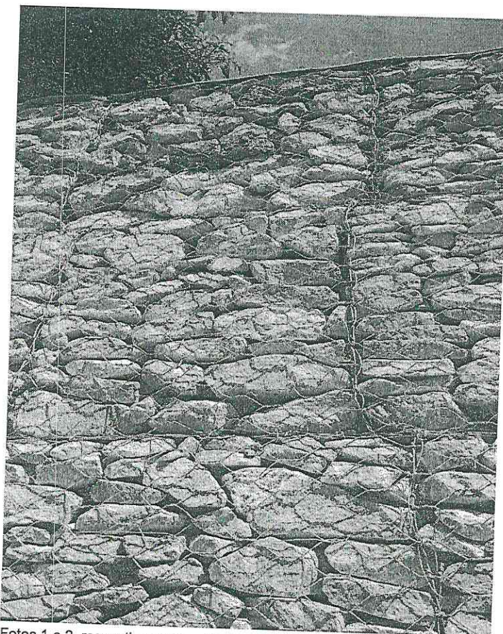
Fotos 1 e 2, respectivamente – Muro gabião
