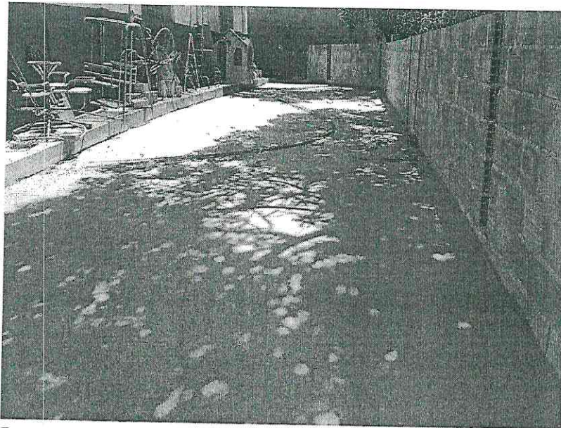
Fotos 3 e 4, respectivamente – Piso executado – Parquinho
