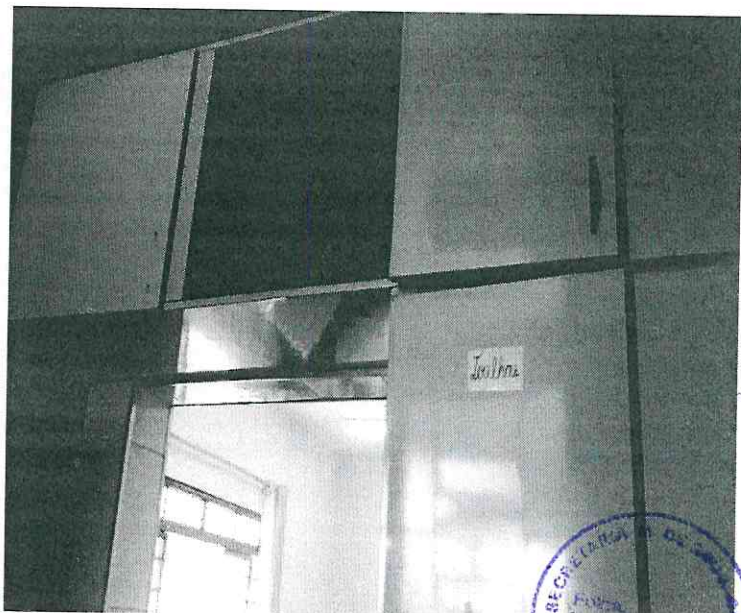
Figura 4: Demolição de armário
