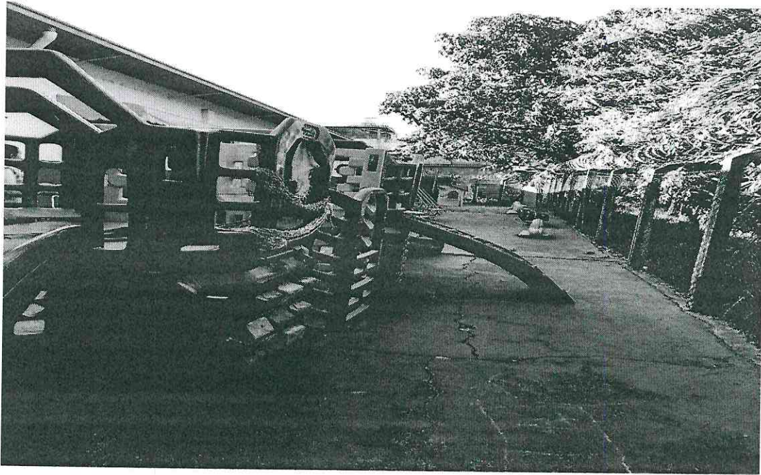
Figura 5: Local para instalação de cobertura
