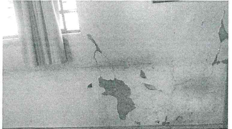
Figura 6: Paredes descascando
