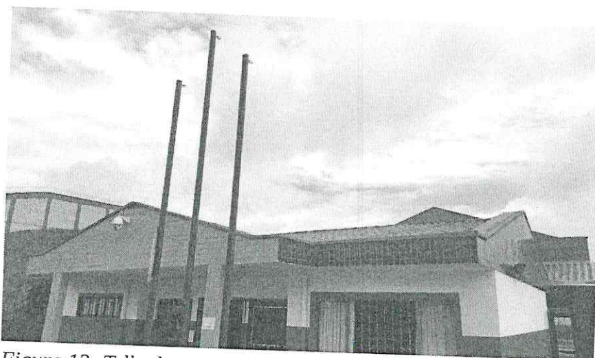
Figura 13: Telhado para ser reformado e impermeabilizado
