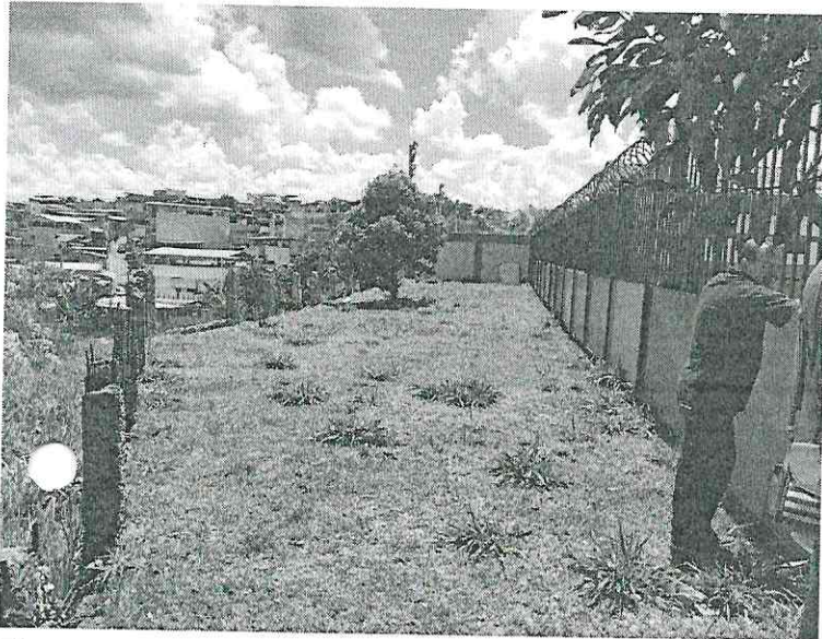
Figura 4: Reconstrução de muro antes existente.
