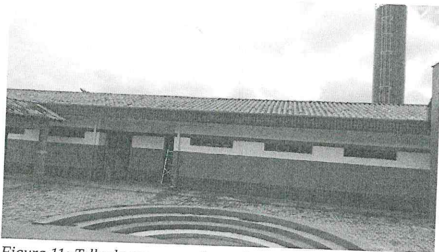
Figura 11: Telhado para ser reformado e impermeabilizado
