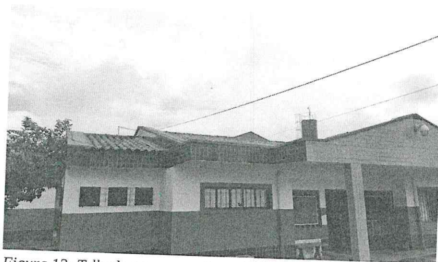
Figura 12: Telhado para ser reformado e impermeabilizado
