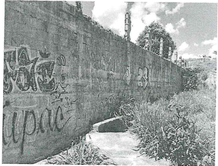
Figura 5: Adaptação na drenagem do muro para não comprometer o muro a ser construído.
