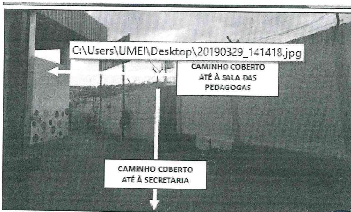
5. Área da entrada – instalar cobertura e calhas.
