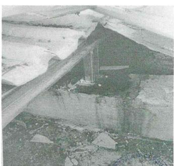
Obs.: Vista do telhado e estruturas danificados pelo temporal: pontos de alagamento e infiltração
