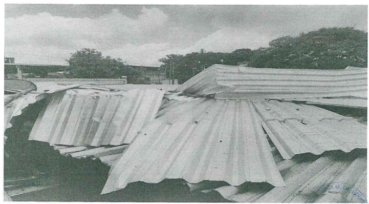
Obs.: Vista do telhado danificado pelo temporal: telhas e estrutura destruídas.
