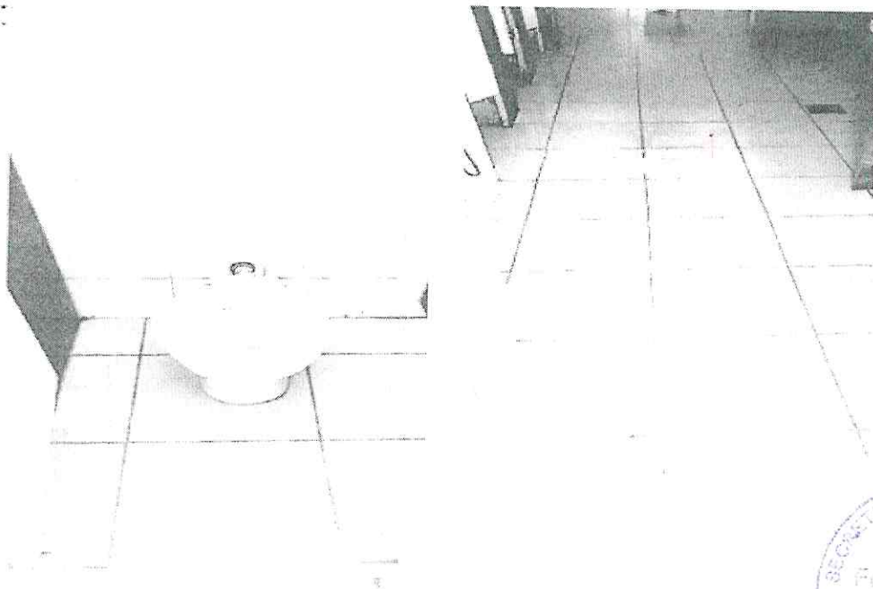
Figura 3: ausência de válvulas de descarga e piso do banheiro.
