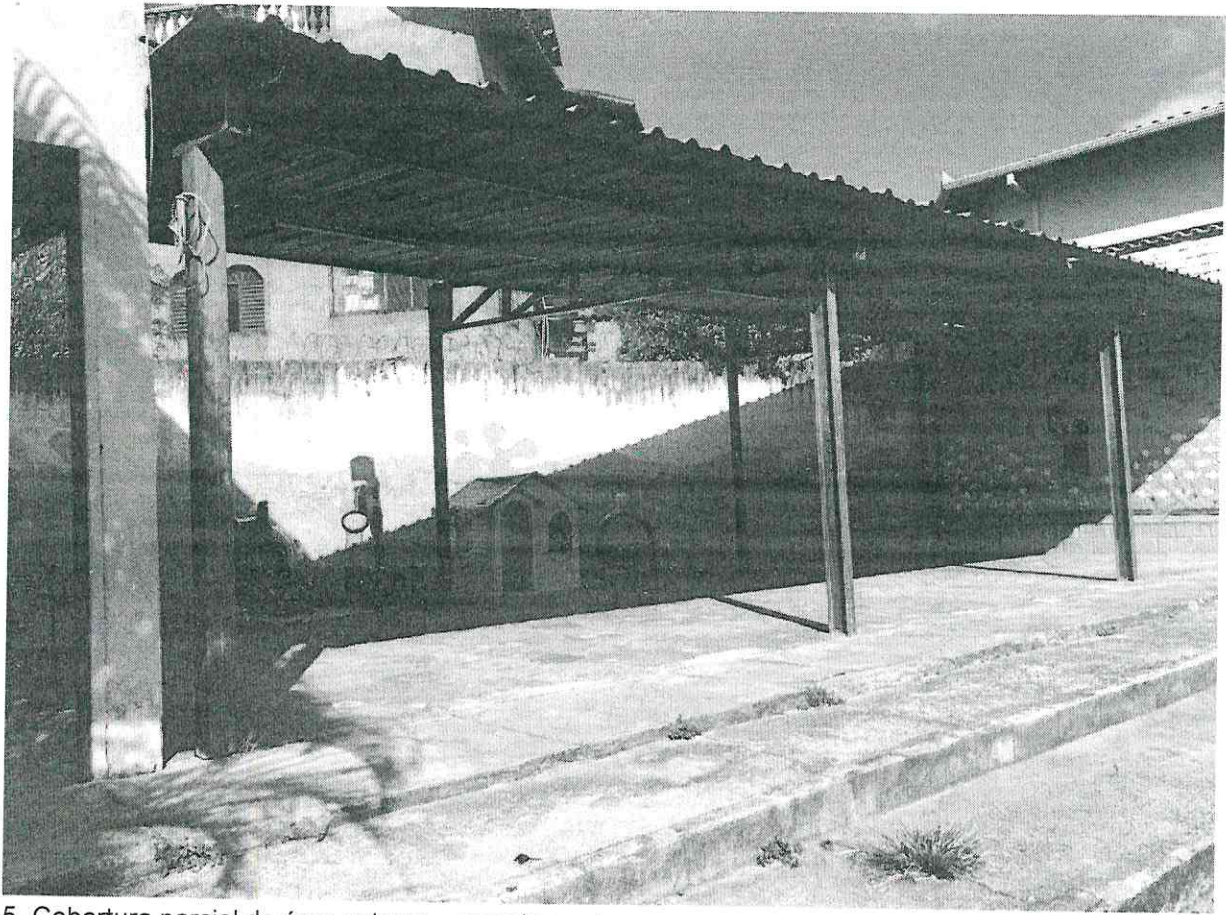
5. Cobertura parcial da área externa - complemento.
