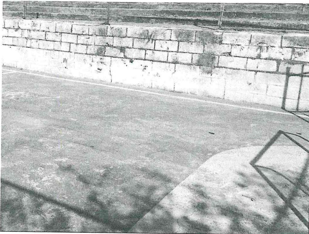
1. Quadra infantil onde será instalada a cobertura
