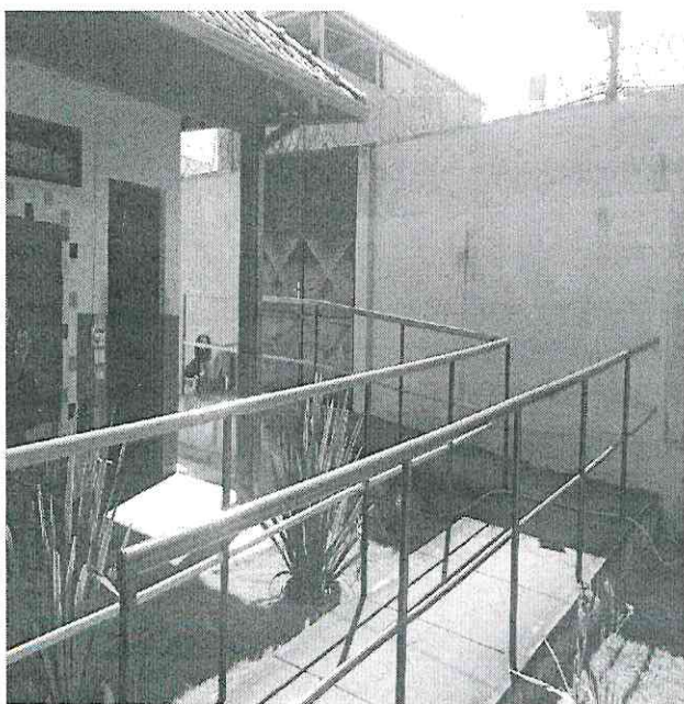
3. Entrada principal – construir cobertura para a rampa.
