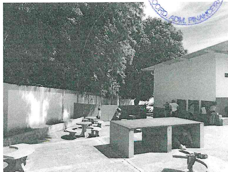
Figura 4: Demolição do muro para ampliação do espaço
