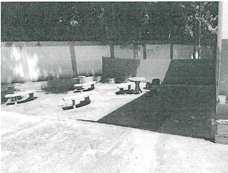
Figura 3: Muro a ser demolido
