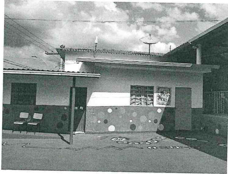
Remoção de calha
