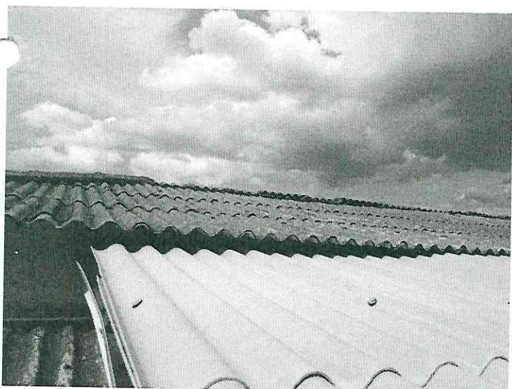
Remoção da telha de amianto
