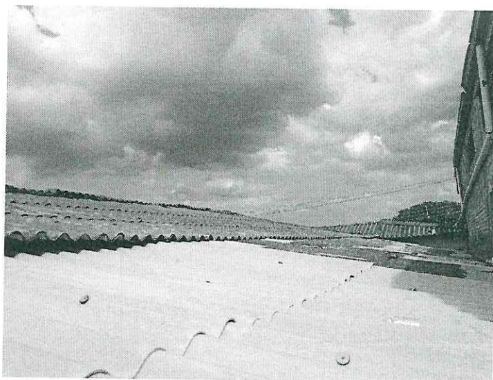
Remoção da telha de amianto
