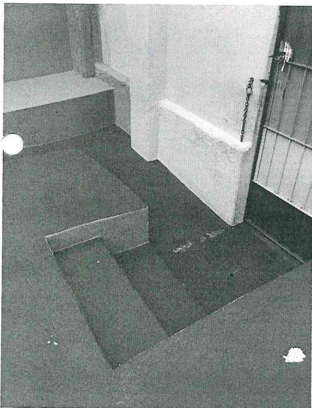
Figura 1: Escada de entrada.
