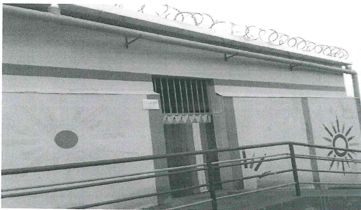
3. Rampa de acesso sem cobertura.
