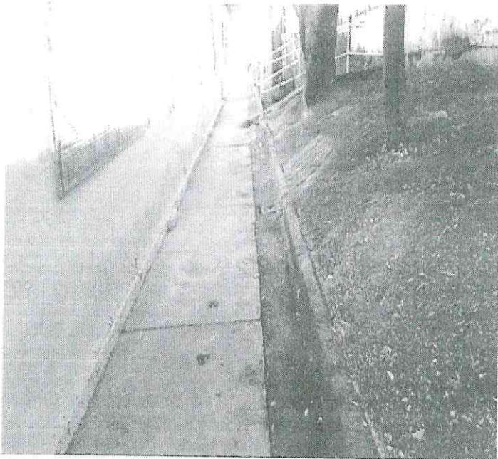
1. Canaletas – realizar limpeza pesada.
