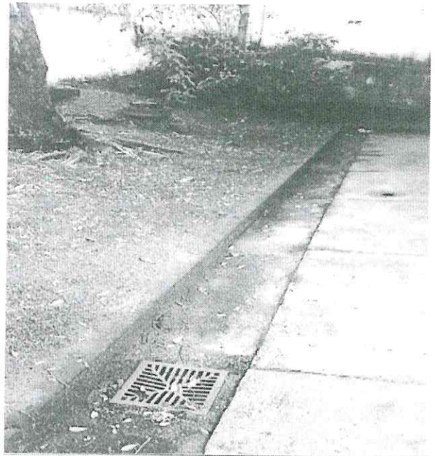
2. Canaletas – realizar limpeza pesada.
