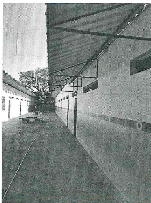
Pintura externa dos blocos
