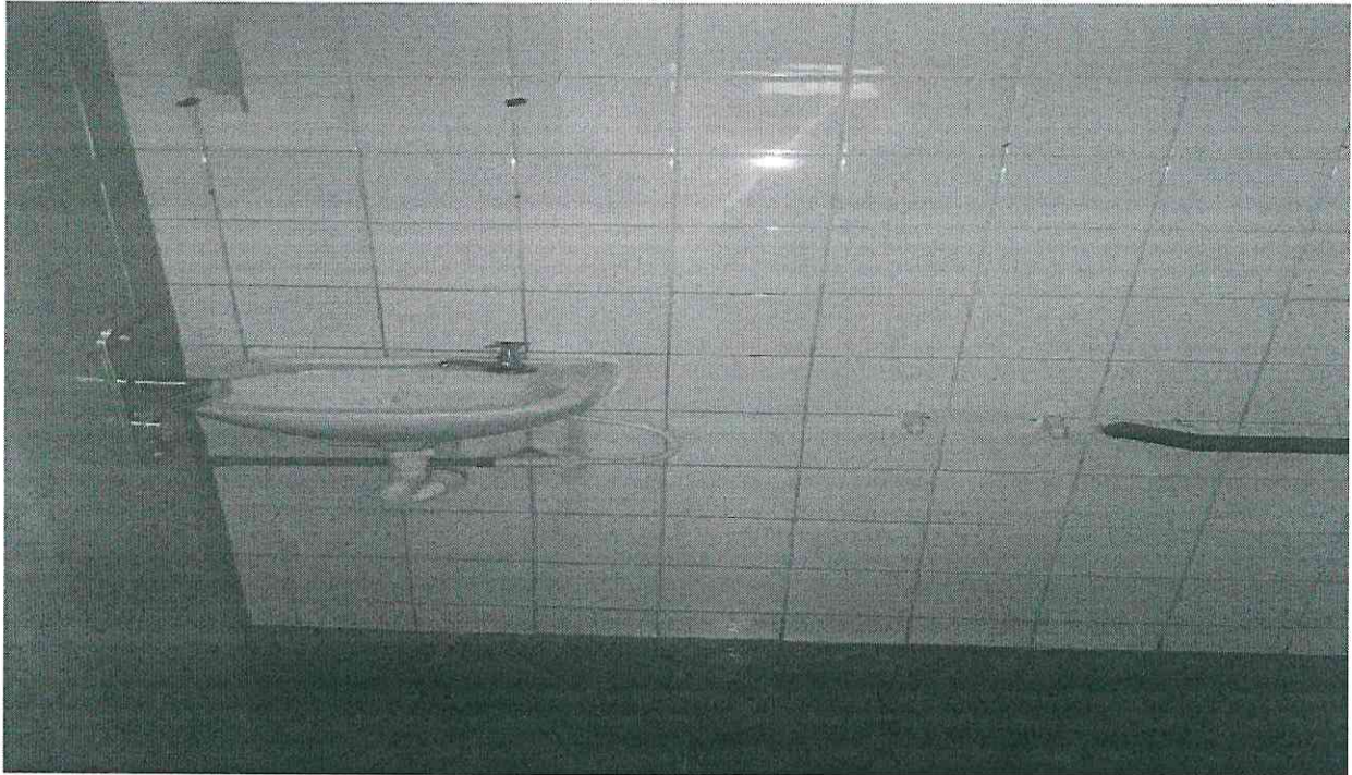
5. Vista do banheiro.
