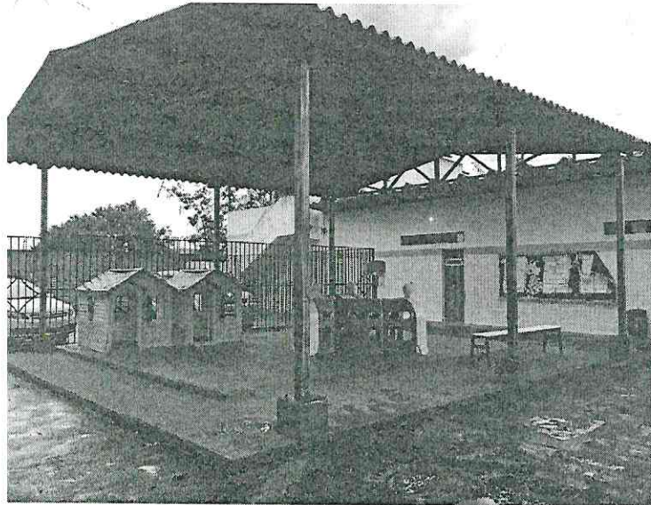
Figura 1: Local para construção da sala de aula.
