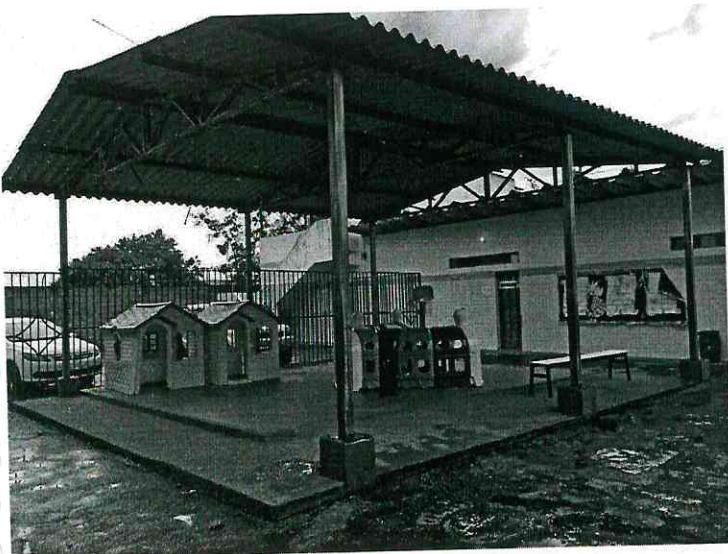
Figura 1: Local para construção da sala de aula.
