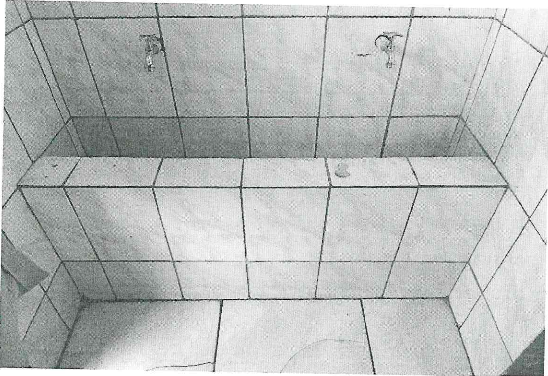
“Instalação de ralo”
