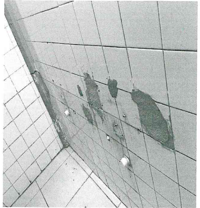
4. Manutenção nos banheiros.
