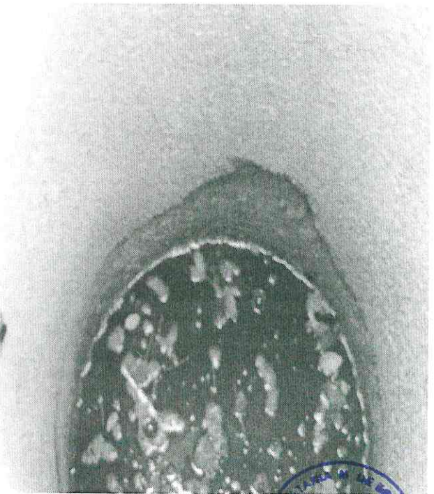
6. Caixa de esgoto entupidas.
