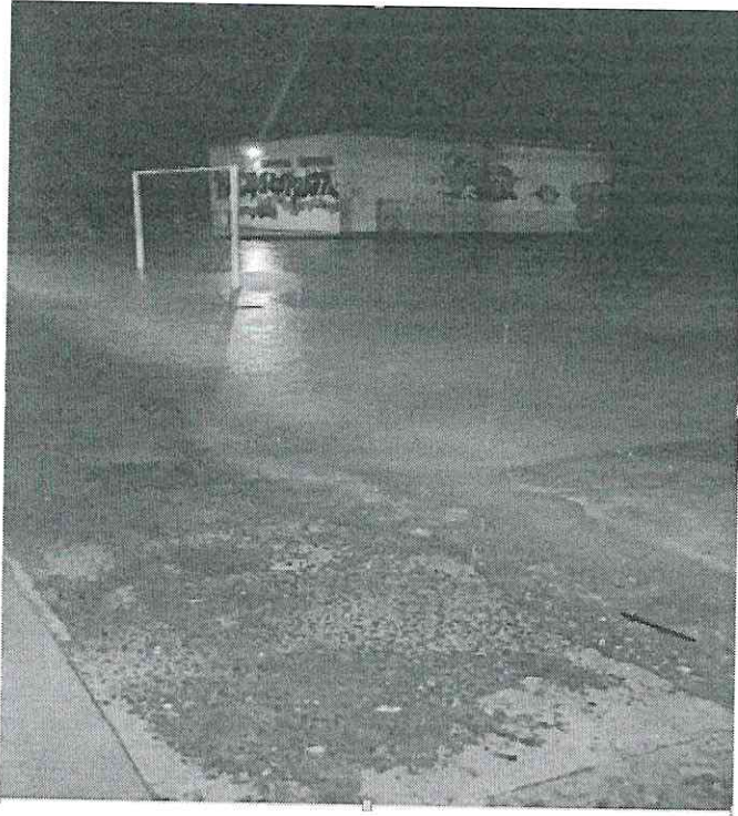
5. Alagamento na área de recreação – demanda drenagem.
