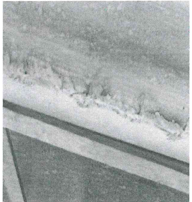
2. Telhado – remendos com concreto.
