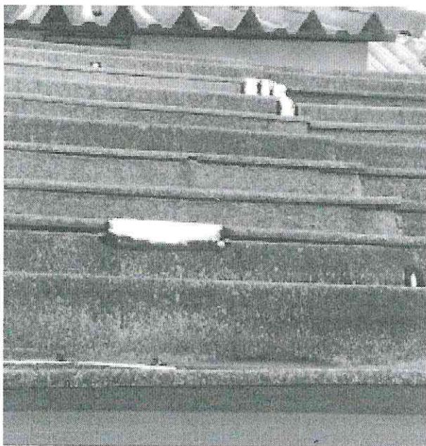
3. Telhado – vista de reparos com cimento.
