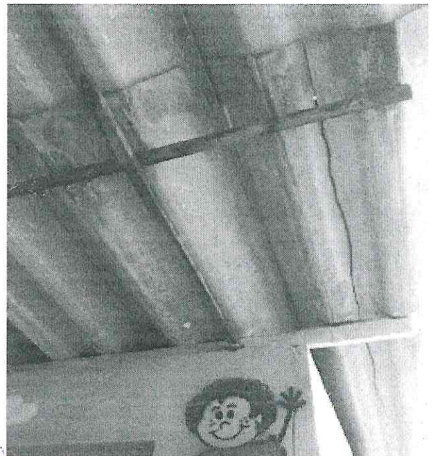
4. Telhado – trincas na extensão.
