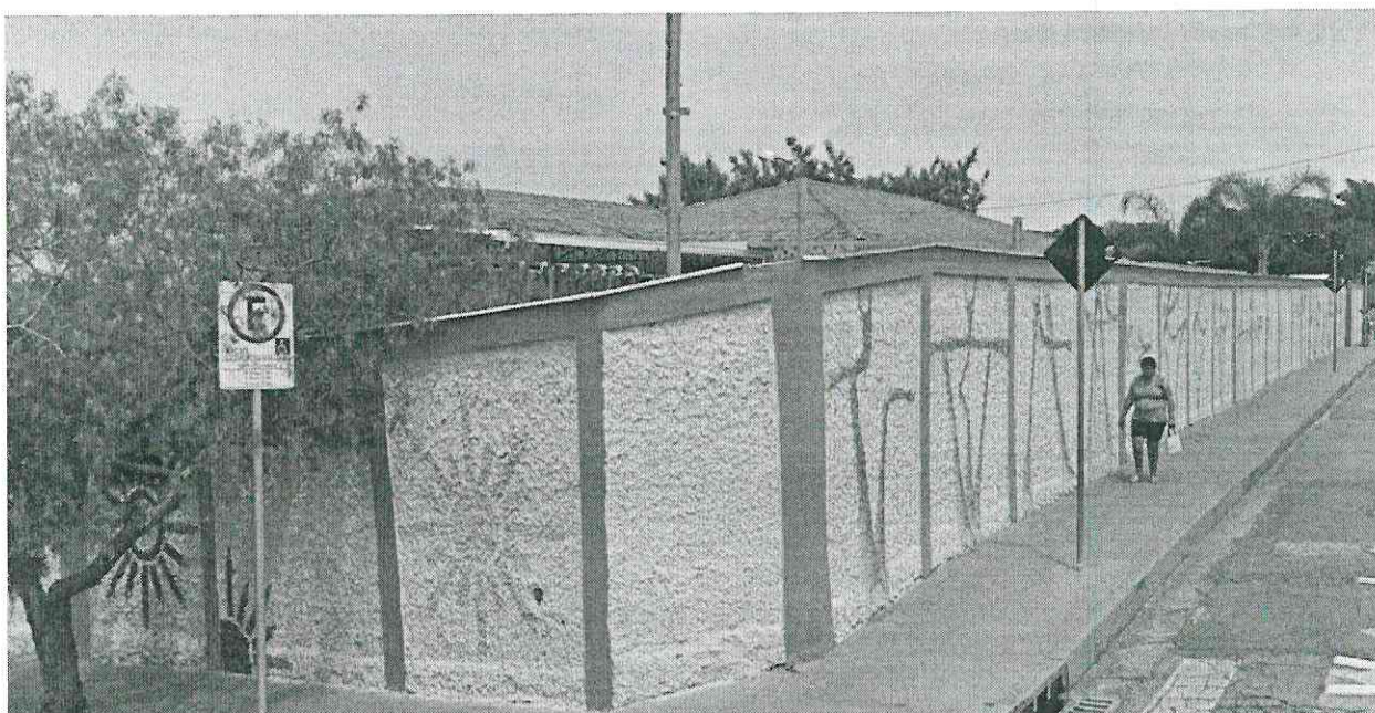
Figura 1: Muro ao entorno da UMEI.
