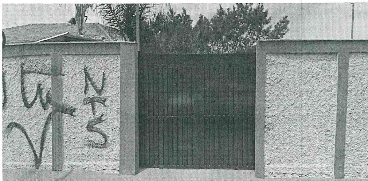
Figura 2: Portão a ser automatizado.
