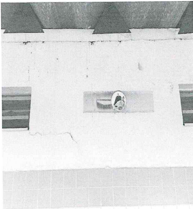
1. Fiação elétrica exposta.
