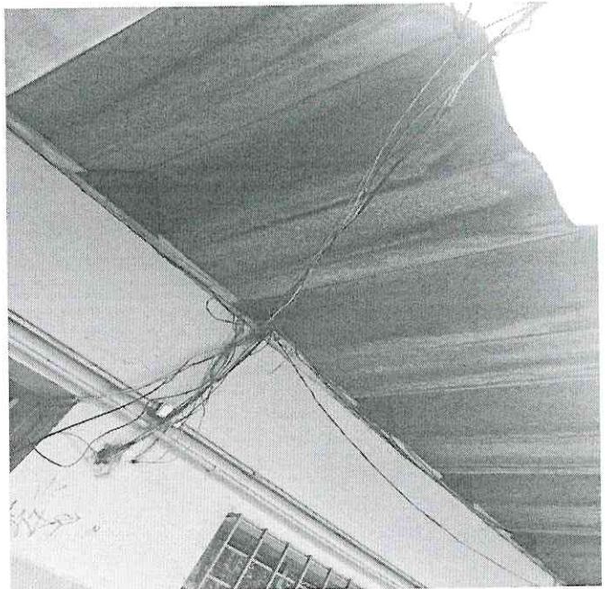
2. Fiação elétrica exposta.
