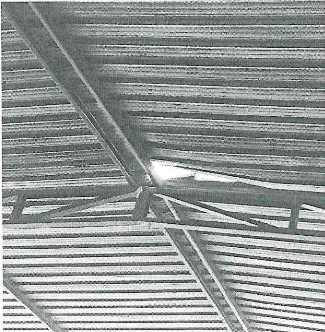
5. Telhado danificado.
