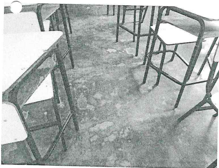
Figura 3: Trocar piso existente por piso cerâmica
