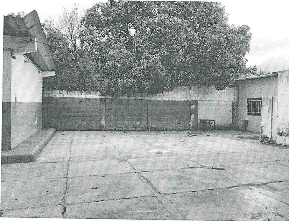
Figura 5: local onde será construído sala de aula
