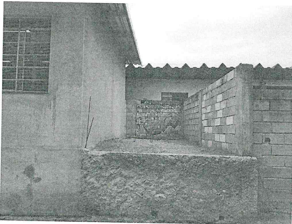
Figura 6: Local onde será construído nova secretaria
