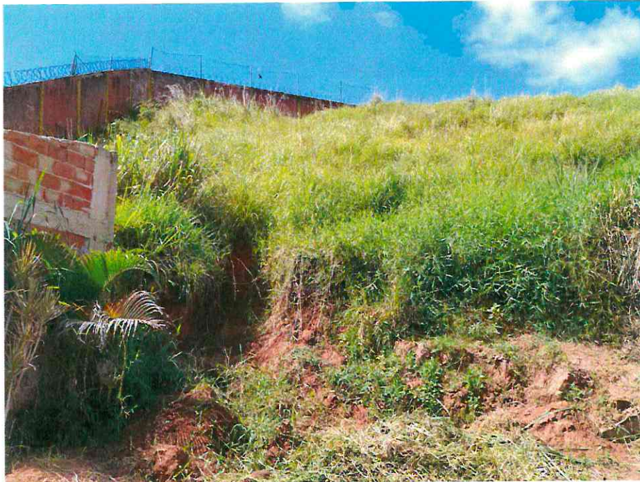
Figura 3: O muro esta comprometido devido a movimentação de terra
