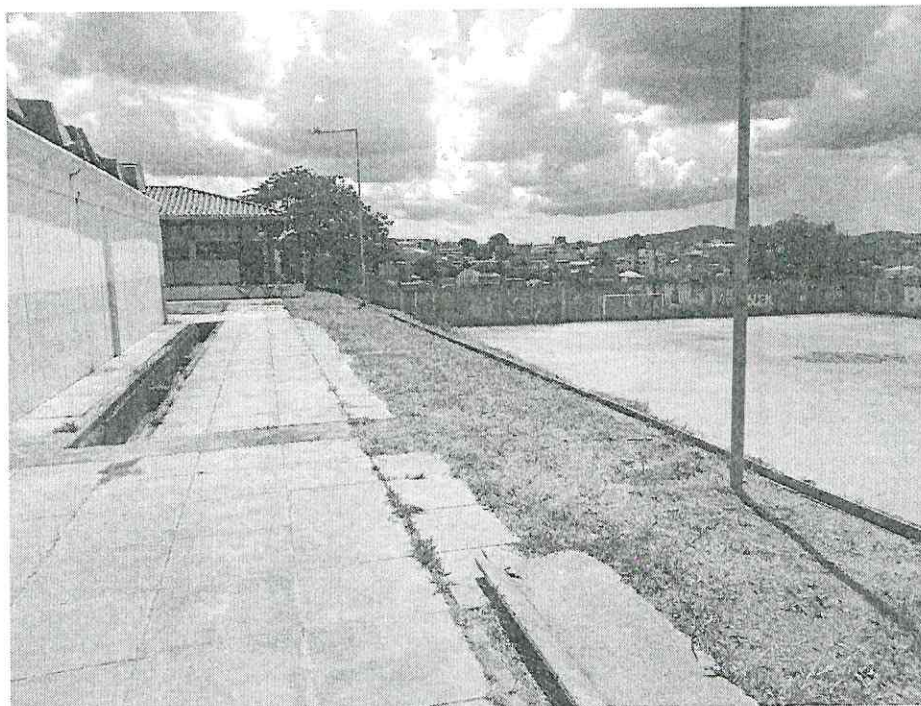
Figura 4: Instalação de cerca
