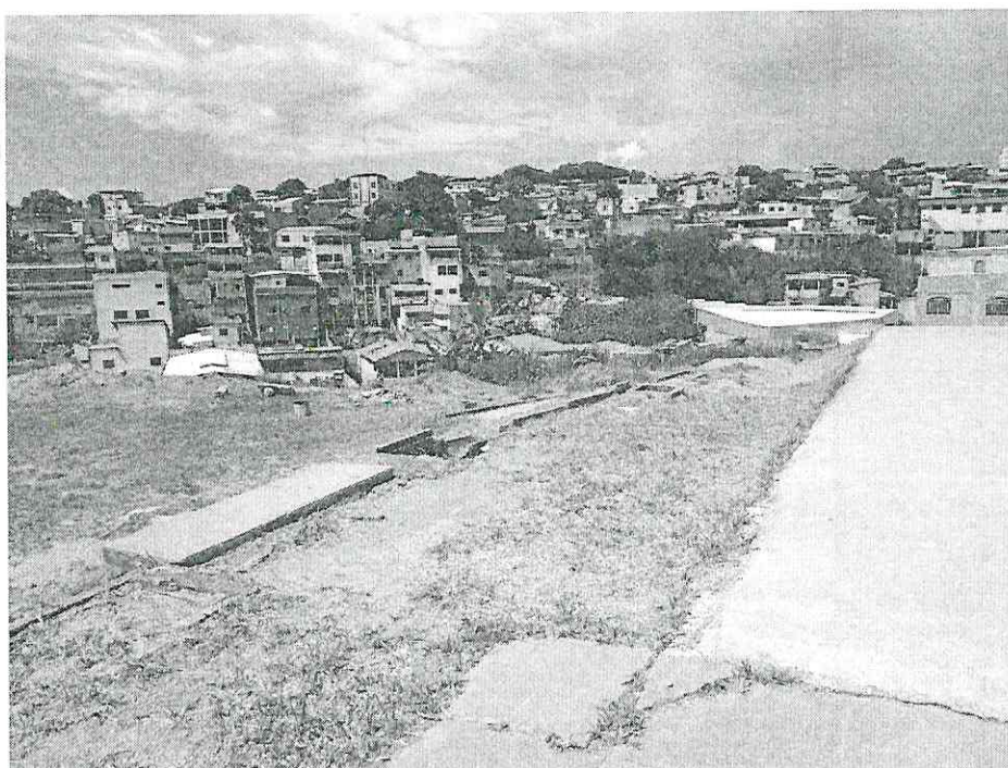
Figura 5: Instalação de cerca
