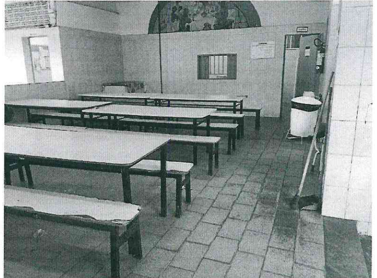
Piso do refeitório
