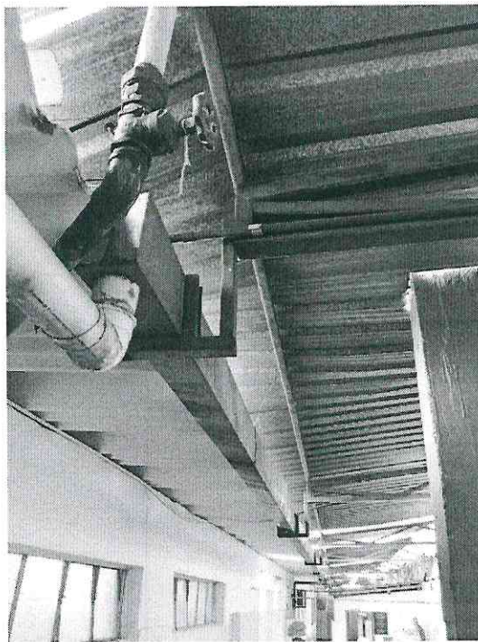
Calha do telhado danificado
