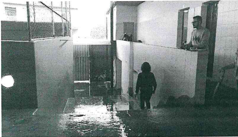
Instalação de grade nas portas das salas de aula
