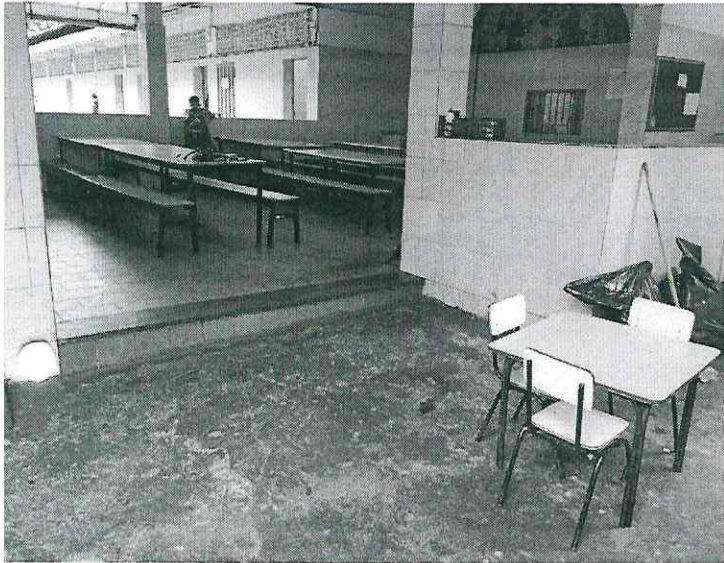
Piso do refeitório
