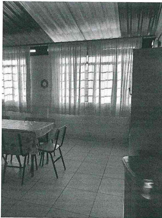
Vista de duas janelas para colocar a grade.
