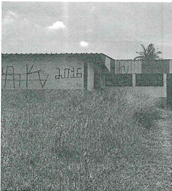
1. Vista da área de construção das salas de aula.
