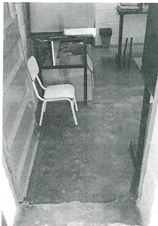
Troca de piso
