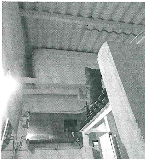
5. Banheiro - caixa d'água a ser transferida para área externa.
