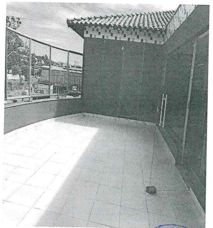
4. Área do solário sem cobertura.
