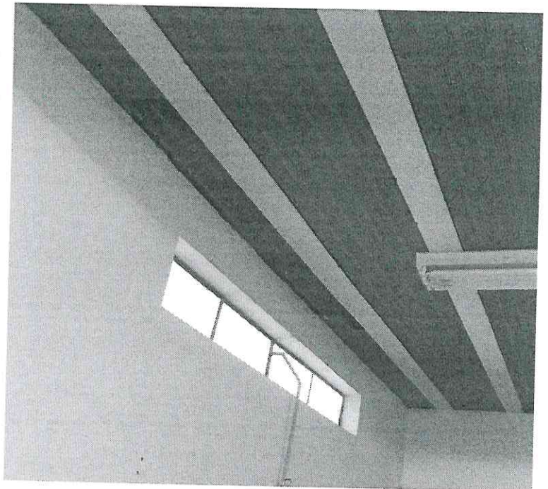
Figura 11: Sala da Biblioteca com bloco cerâmico fragmentado
