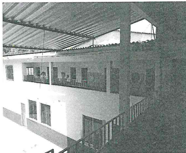
Figura 11: Anexo para receber pintura.
