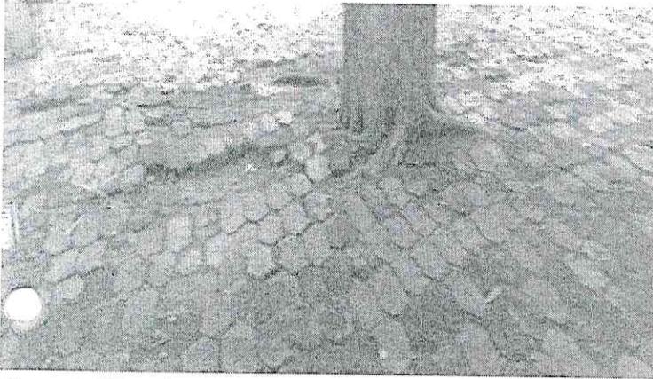
Figura 1: Piso de concreto para reforma.
