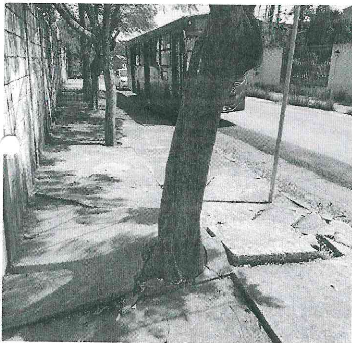
1. Calçada de entrada da escola.
