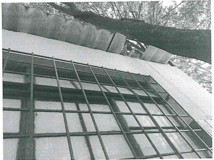
Figura 6: Telhado da sala de projetos.
