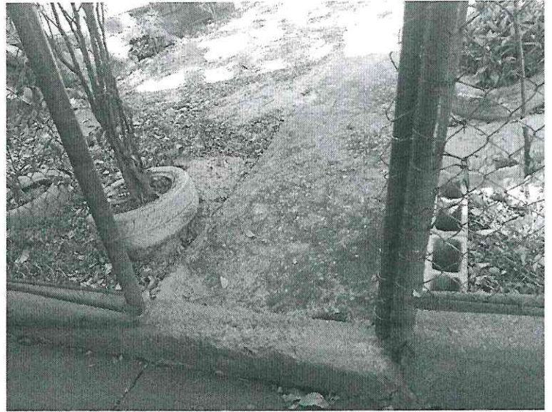
Figura 9: Entrada de acesso para a rampa.
