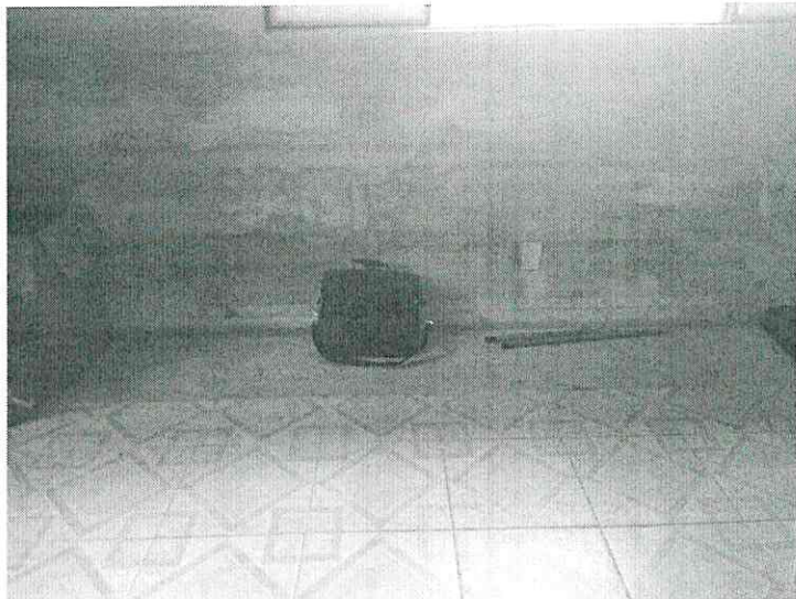
Troca de piso da sala de informática.
