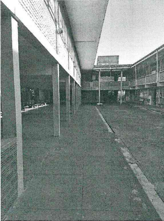
Cobertura do acesso ao pátio.
