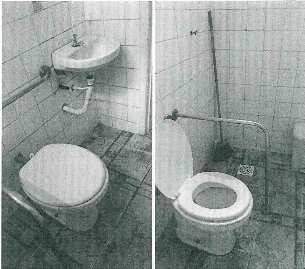
Reforma geral do banheiro dos professores.
