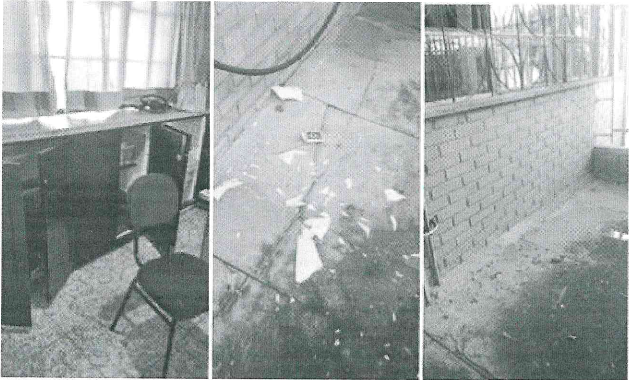
5. Instalação de grades nas janelas – medidas antiarrombamentos.
